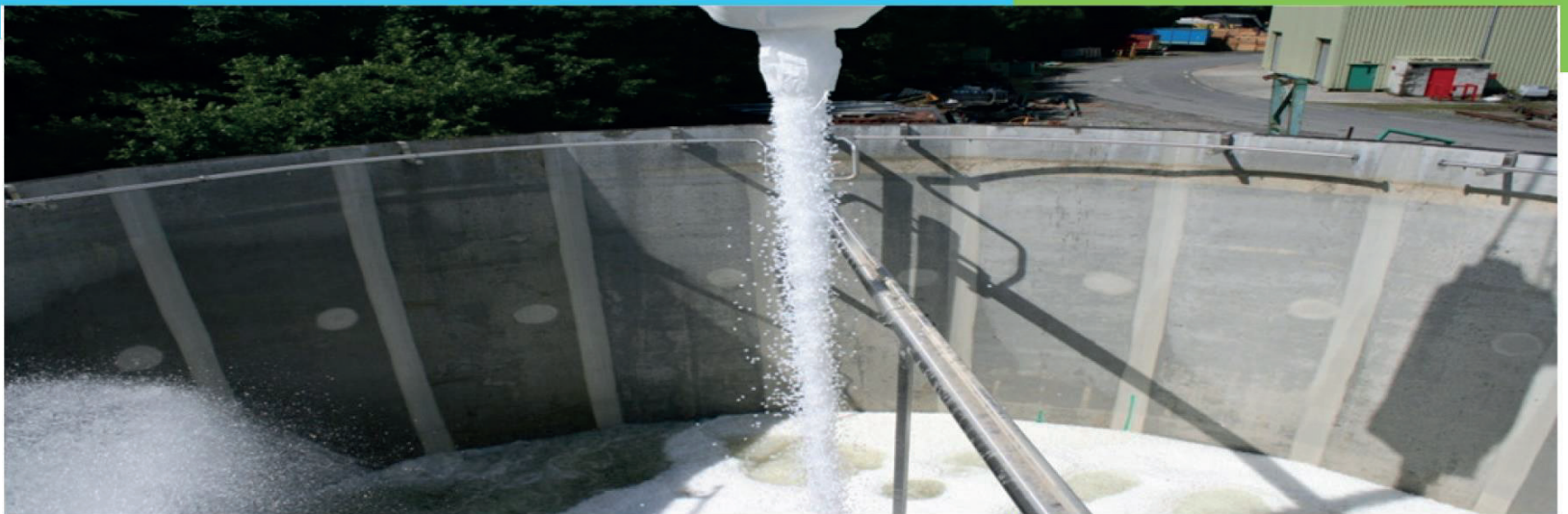
Riempimento del bioreattore con carrier
